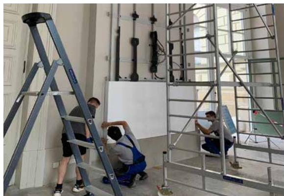
Montage der Umhausung
