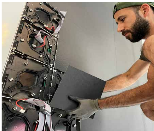
Montage der LED-Module
