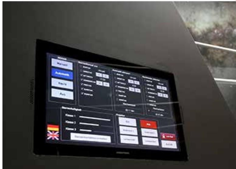
Parallel zur Bedienung über das passwortgeschützte 15“ Wandtouchpanel CRESTRON® TS-1542 steht hier auch ein Funktouchpanel mit denselben Funktionen zur Verfügung, das ein freies Bewegen im gesamten Bereich der „Void“ zulässt.
