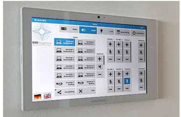
CRESTRON® 10" Touchpanel für die Steuerung der Medientechnik inklusive Licht- und Gebäudesteuerung
